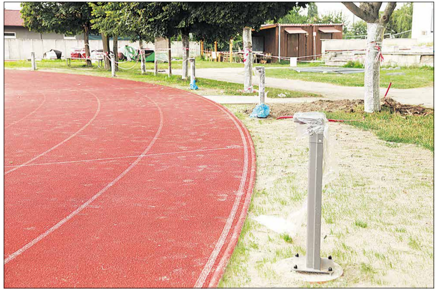
Rekonštrukcia atletickej dráhy v ZŠ Záhorácka.
