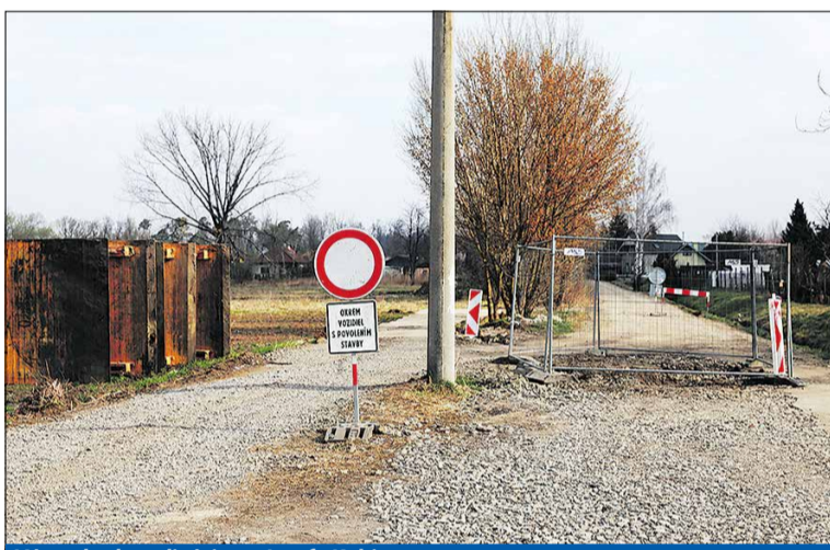
Výstavba kanalizácie na Jozefa Kubinu.
