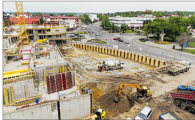
Výstavba hromadnej podzemnej garáže je v plnom prúde
