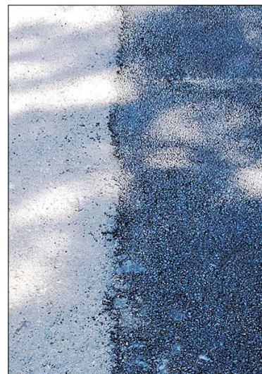
Prepojenie starého a nového asfaltu pri použití Silkot Blue – nevyzerá síce tak pekne ako frézovanie, ale vydrží dlhšie
