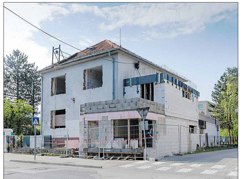
Rekonštrukcia a prístavba Vstúpte
