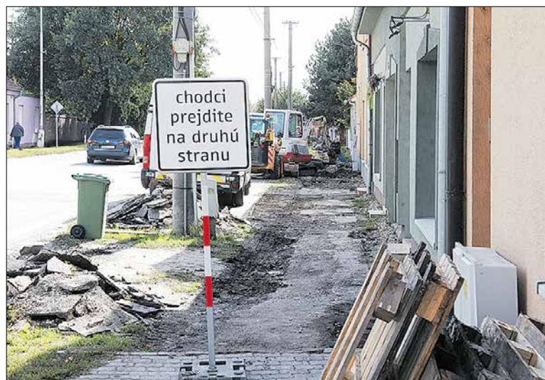
Rekonštrukcia chodníka na Štefánikovej
