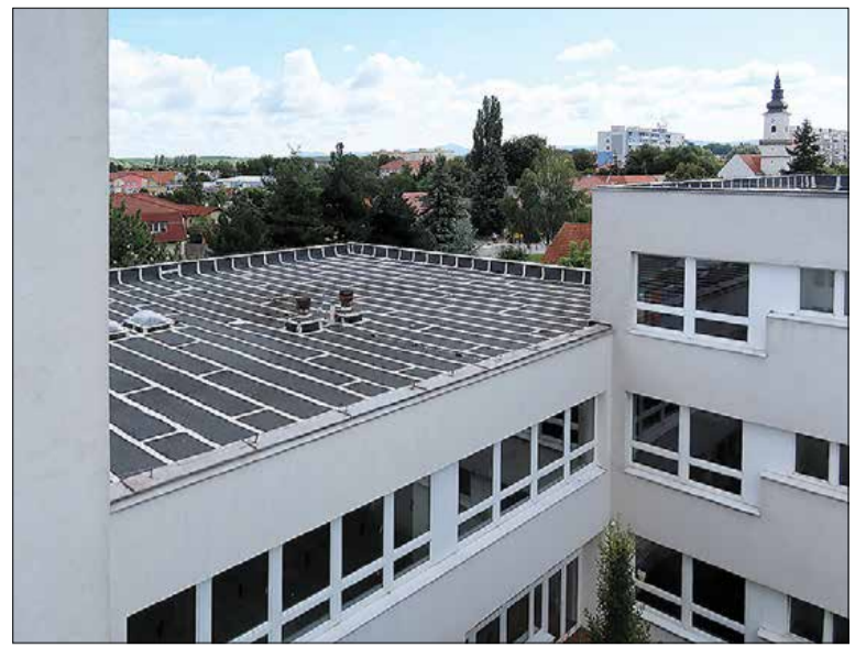
Opravená strecha ZŠ Záhorácka
