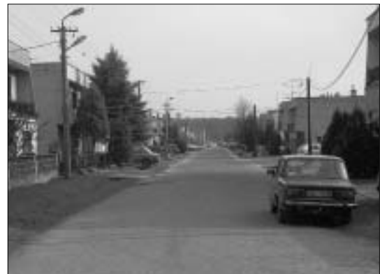
Miestna časť Jazero si svoj názov zaslúži. Stačí trochu dažďa a jej obyvatelia už čerpajú vodu z pivníc.
