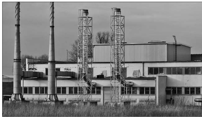
Celkový pohľad na zdroj tepla zo strany odvodu spalín – komínov
