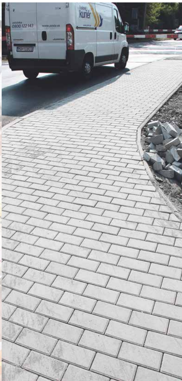
Nový chodník od Nádražnej k železničnému priestrešku
