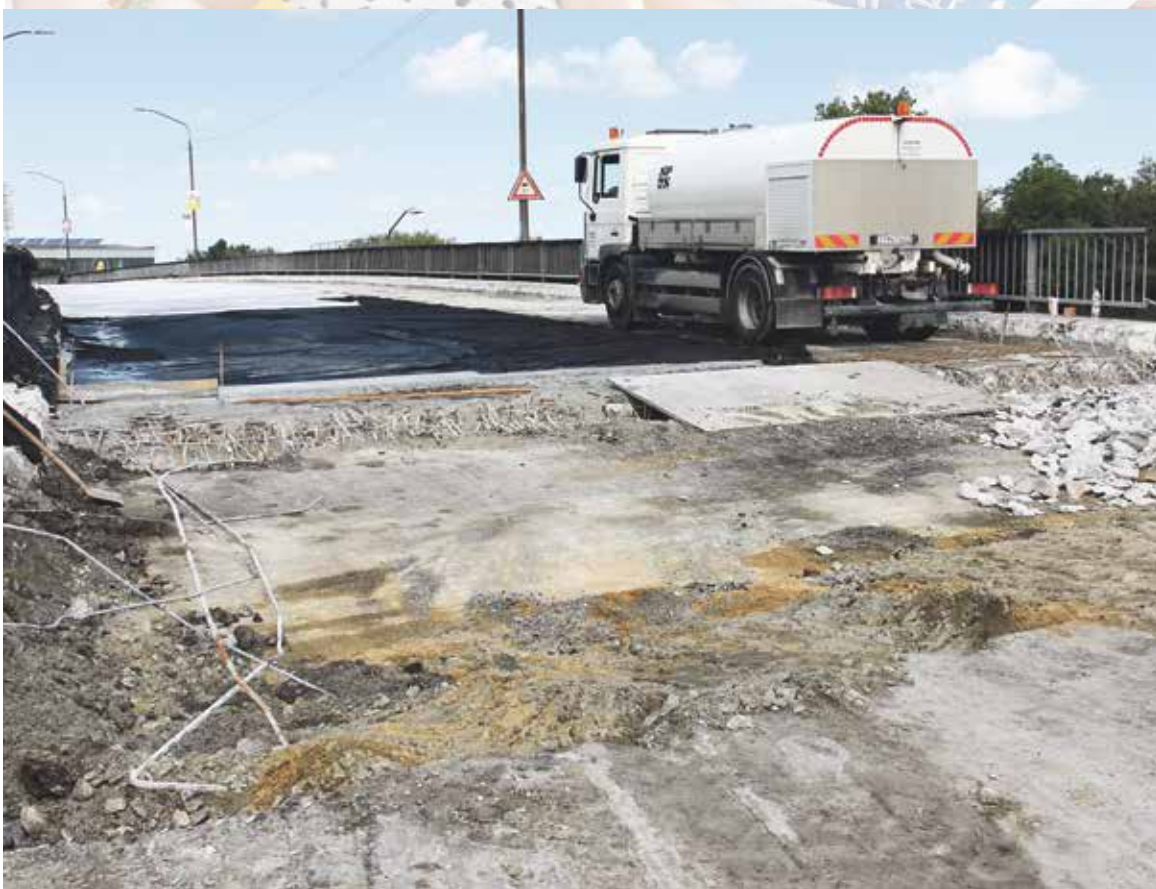
Rekonštrukcia nadjazdu pokračuje
