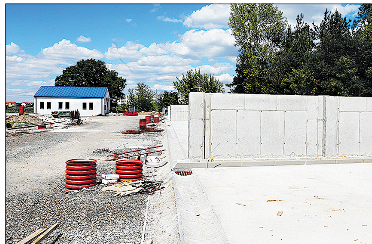
Výstavba mestskej kompostárne
