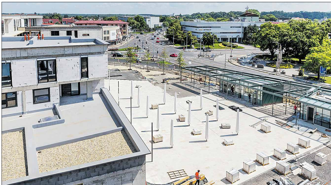
Výstavba pešieho námestia v centre
