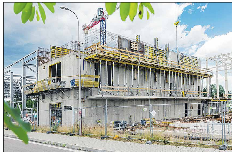
Výstavba Šport arény
