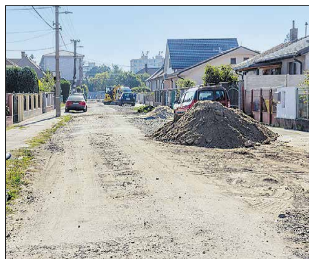
Ulica Martina Benku, rekonštrukcia vozovky sa začne po oprave kanalizácie.
