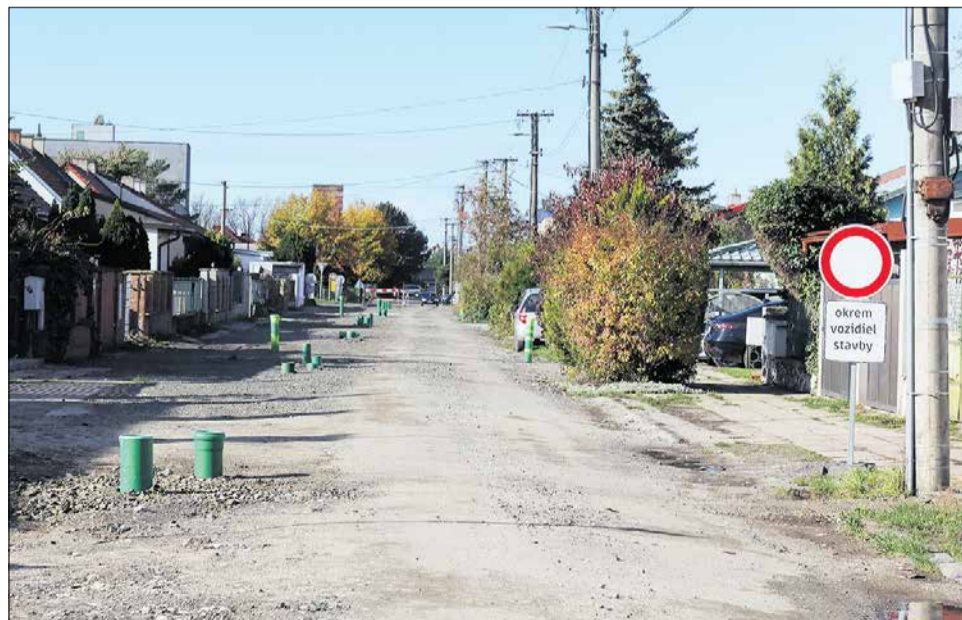
Po oprave kanalizácie na Ulici Martina Benku sa bude rekonštruovať vozovka
