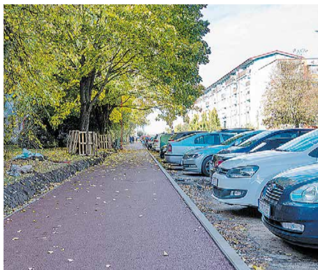
Výstavba cyklotrasy na Velkomoravskej
