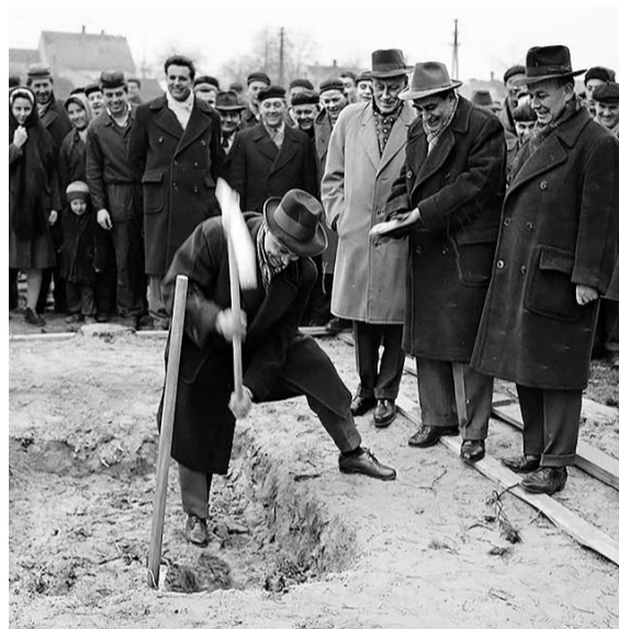
Slávnostný výkop základov. Foto: archív TASR, Koloman Cích
